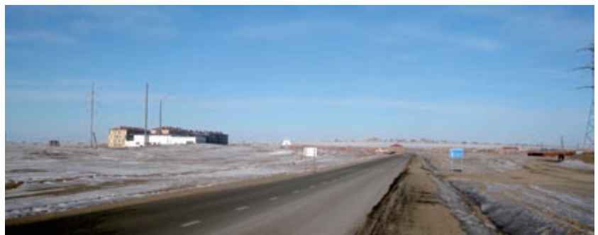
Tavantolgoi機場至礦工營地的柏油路
