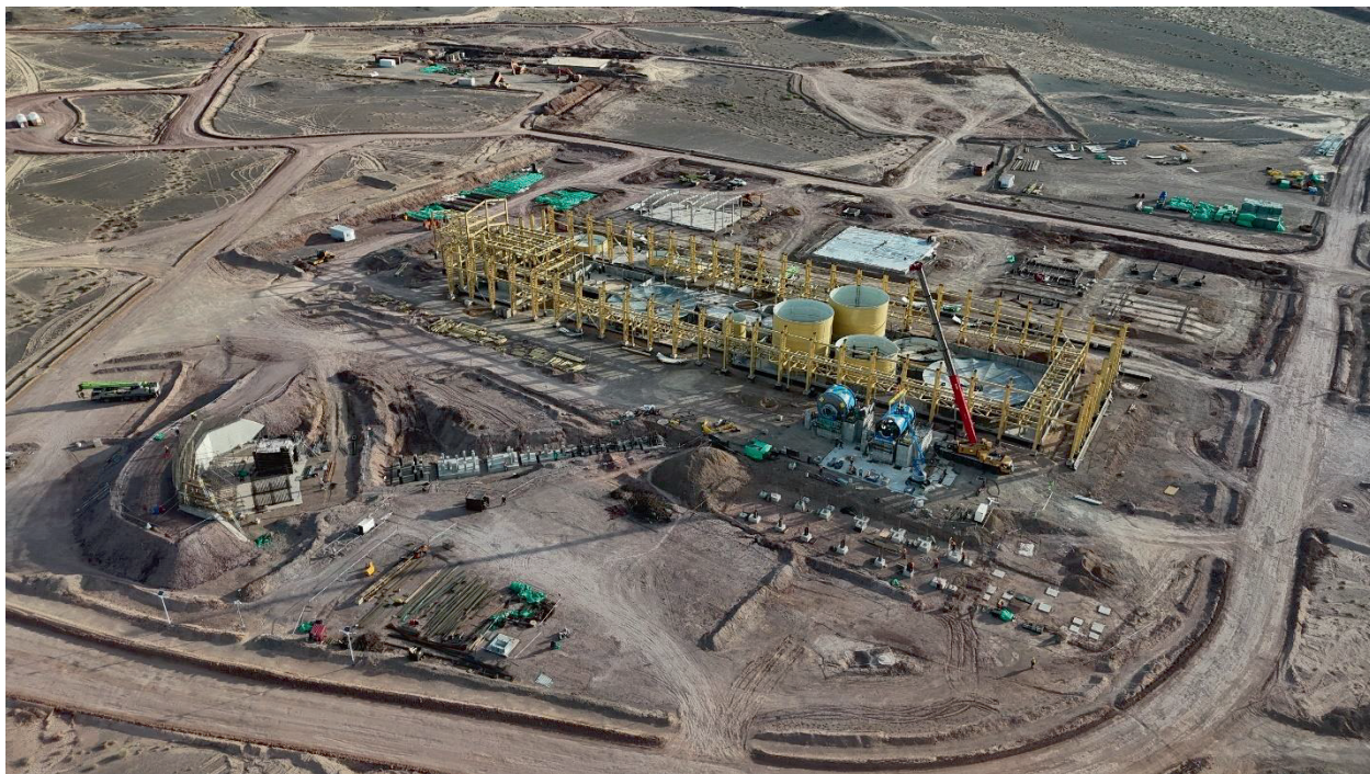
照片：二零二四年七月三十一日BKH礦場的選礦廠建設。
